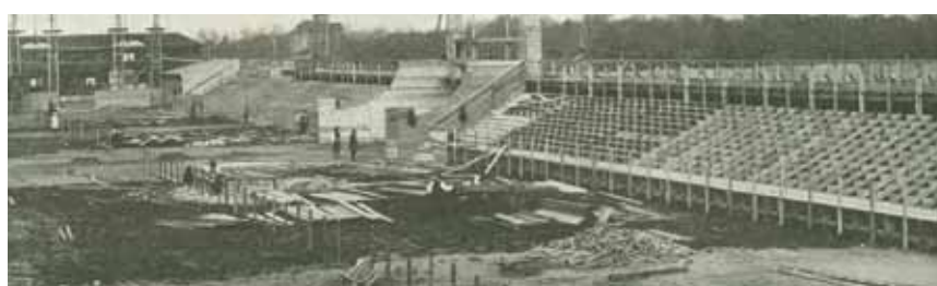
Stavba postranní tribuny
