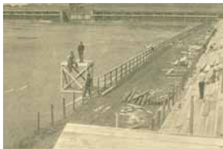
Cvičiště při stavbě
