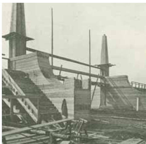
Stavba brány borců
